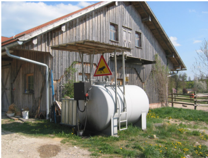
Eine Pflanzenöltankstelle in Bayern: Im Gegensatz zu Diesel oder Methylester sind reine Pflanzenöle keine explosiven oder wassergefährdenden Gefahrstoffe
