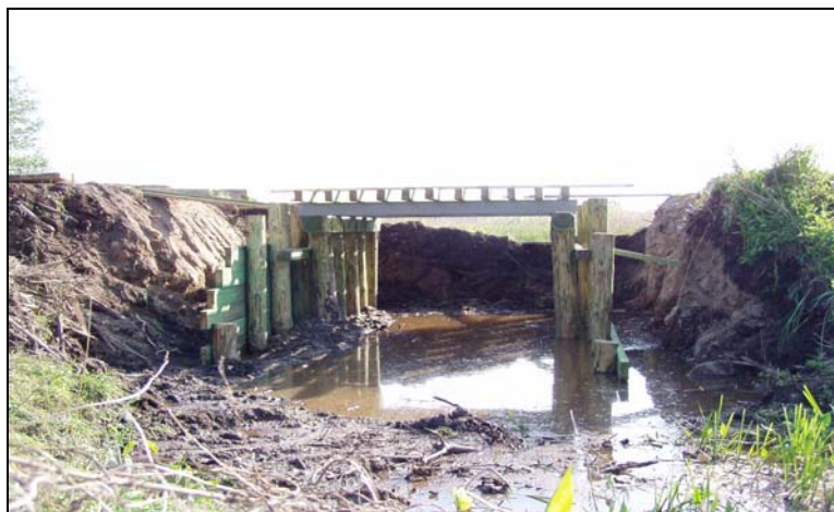
Bild 2: Eine neue Brücke auf dem Weg zwischen Rzędziany und Pańki
