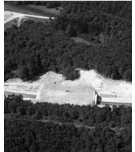
Grünbrücke im Bau. Erste Grünbrücken sind nun auch in Polen bewilligt. Hier an der Autobahn A-18 an der polnisch-deutschen Grenze.
