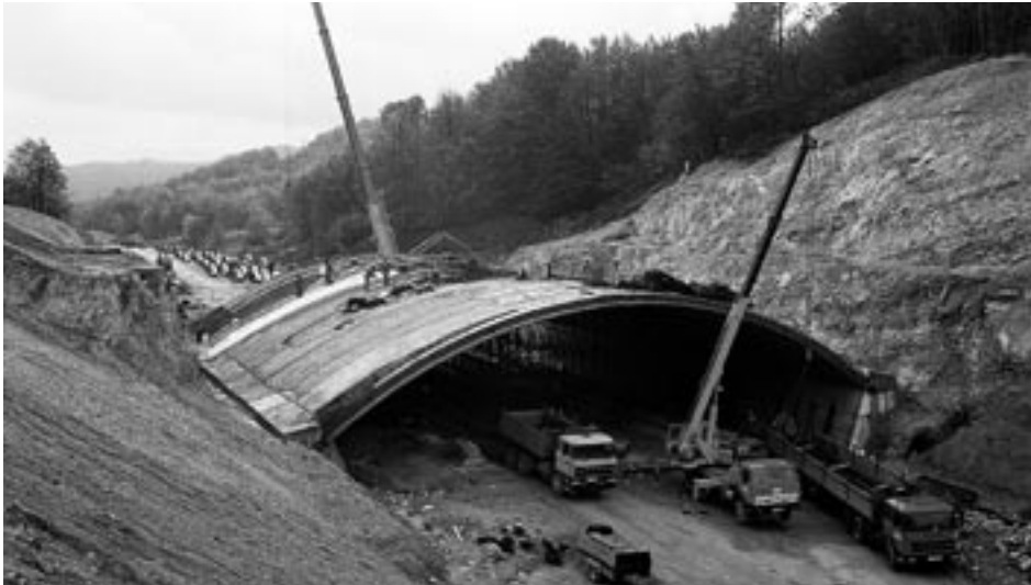
Inzwischen erfolgreich von Großraubtieren genutzt: die Grünbrücke Dedin in Kroatien - hier noch im Bau.
