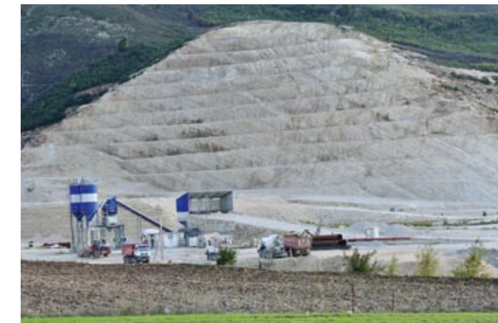
Die Bauarbeiten am Kalivac-Staudamm ruhen derzeit, können aber jederzeit weitergehen.
