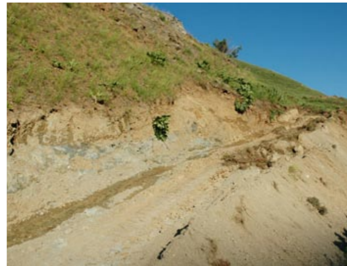
Obwohl die Weltbank noch keinen Kredit zugesagt hat, laufen in Lukovo Pole bereits erste Bauarbeiten.
